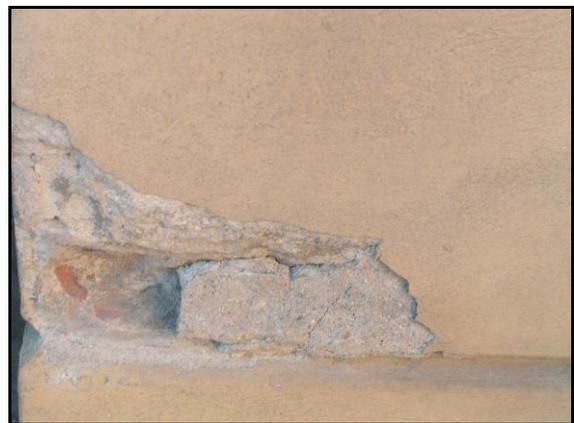
Il degrado degli intonaci è causato anche dalla erosione provocata dagli agenti atmosferici (precipitazioni meteoriche, sbalzi termici, vento, ecc.). La loro azione disgregatrice, quando un intonaco è realizzato utilizzando buoni materiali e nel rispetto delle tecniche di esecuzione, si manifesta però gradualmente nel tempo perché la resistenza opposta dall'intonaco è tale per cui solo piccole parti di materiale vengono asportate.
